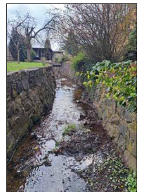
Ufermauern prägen wie hier im Bild viele Gewässer. Foto: Wetzelt, LfULG
